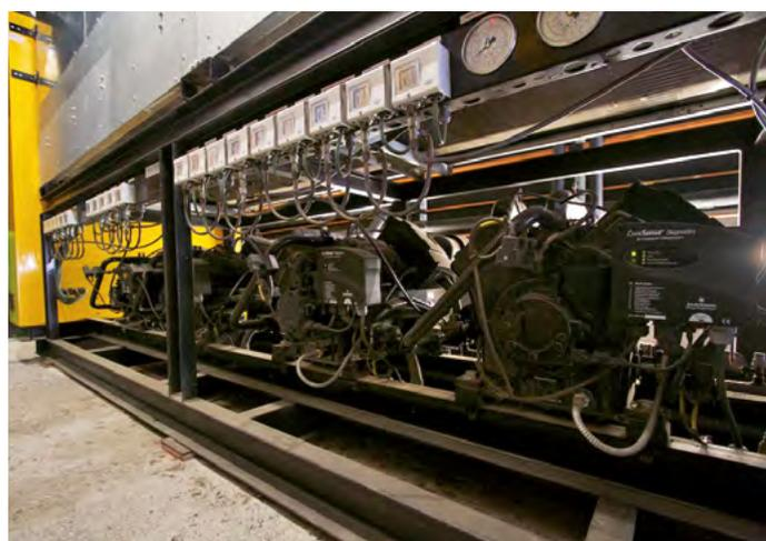
La solución ha permitido reducir los niveles de consumo eléctrico y el coste de funcionamiento de la instalación. La exclusiva tecnología de los compresores hace que éstos sean más eficientes que cualquier otro compresor.
