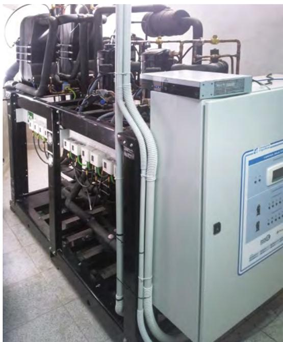
La central de CO<sub>2</sub> con sus dos compresores Scroll y Scroll Digital de 15kW atiende seis recintos frigoríficos de baja temperatura.
