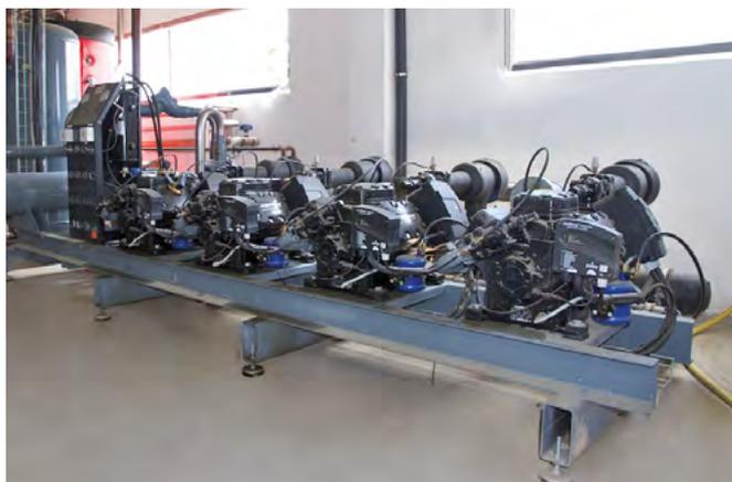
La central Stream instalada da servicio a cámaras, secaderos y obradores destinados a la fabricación y conservación de queso.
