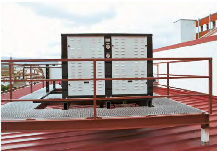
Con sólo dos compresores Stream de 22 CV con reducción de capacidad se atiende cómodamente las tres cámaras frigoríficas de conservación de embutido y producto cárnico.
