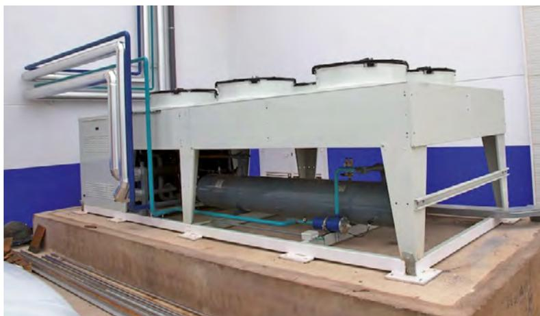
La central roof-top queda concentrada en una sola bancada facilitando así su accesibilidad, manejabilidad y control.
