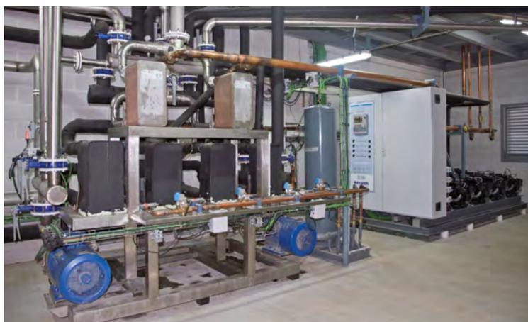
La recuperación del calor de condensación se realiza a través de intercambiadores de placas, que se ubican en una bancada en la sala de máquinas junto a la central frigorífica Stream Digital.
