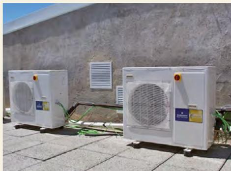
Las mini-centrales ZXD destacan por su sencillo montaje y pueden alcanzar ahorros energéticos de hasta un 50% en relación a otras soluciones.
