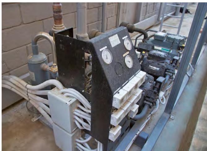
La central frigorífica incorpora dos compresores Stream de 40 CV que atienden la nueva cámara de mantenimiento de producto congelado.
