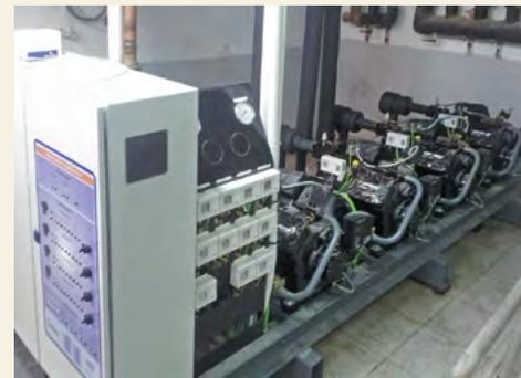
La central de R134a cuenta con 4 compresores semiherméticos Stream de 100kW (uno de ellos Digital) para cubrir los servicios de media temperatura y condensación del CO<sub>2</sub>.
