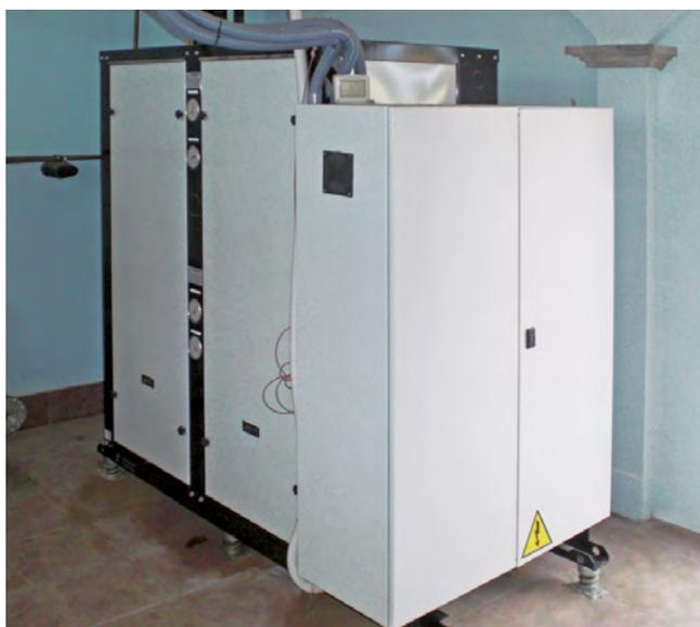
Tras la ampliación del mobiliario frigorífico se instalaron dos nuevas centrales Scroll Digital para alimentar los servicios de temperatura positiva y negativa.
