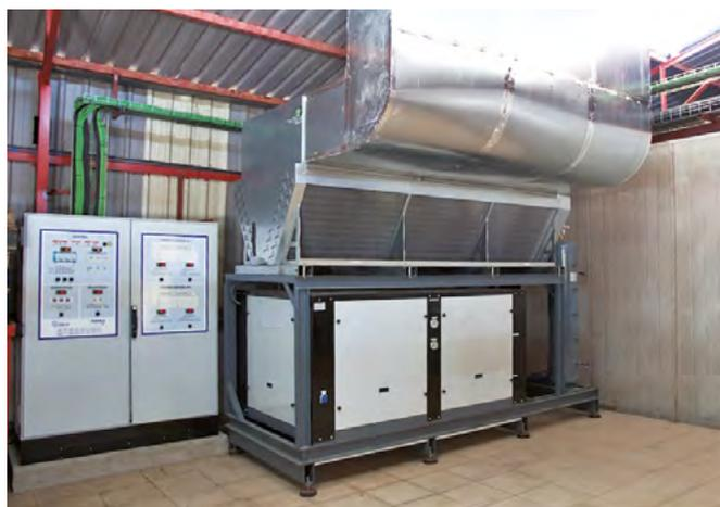
La gran flexibilidad de la instalación frigorífica permite cubrir servicios negativos entre 7 kW y 60 kW.
