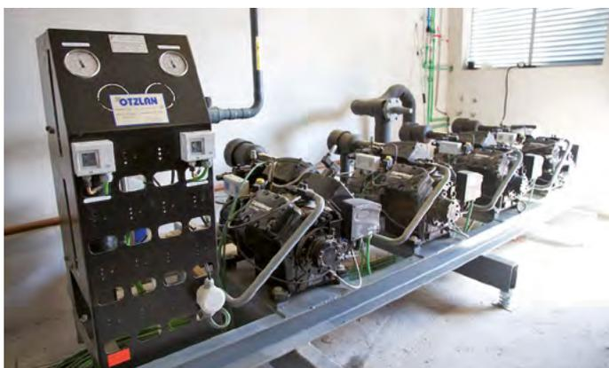
Solución energéticamente eficiente basada en tecnología Stream, ventiladores EC, válvulas de expansión electrónicas y condensación flotante para todos los servicios.
