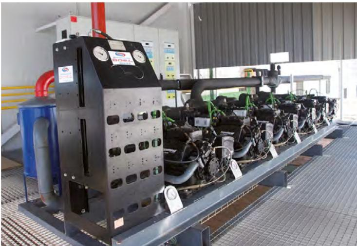
Sala de máquinas exterior en la que se ubicó la central frigorífica que incorporaba seis compresores semiherméticos Stream.
