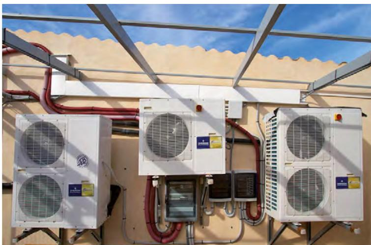
Las unidades ZX Digital Scroll requieren de un menor tiempo de instalación frente a otras alternativas de modulación de capacidad ya que sus compactas dimensiones y su reducido peso facilitan su montaje.
