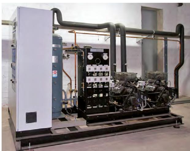
La nueva instalación incorpora compresores Stream de cuatro etapas, válvulas de expansión electrónicas y condensación flotante.
