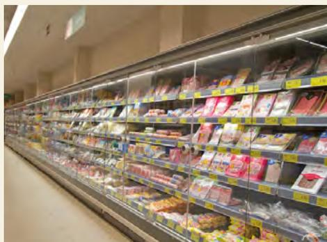
El acristalamiento de los muros refrigerados elimina los pasillos fríos y permite ahorros de hasta un 70%.
