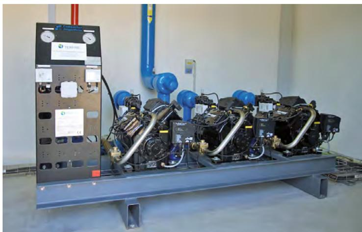
Gracias al módulo CoreSense™ de los compresores Stream, mecánicos y técnicos pueden detectar más rápidamente cualquier problema en el sistema de refrigeración.
