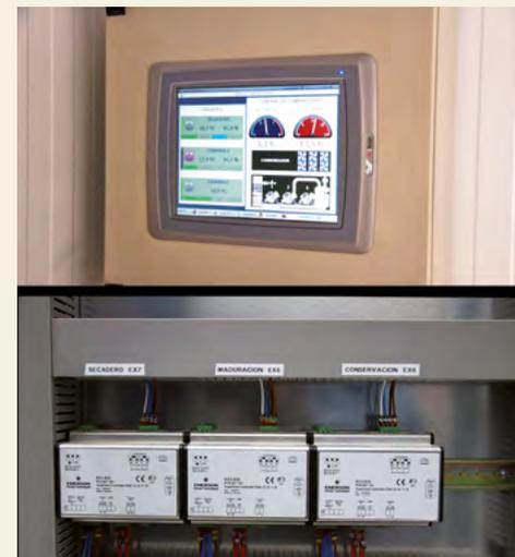
Control de la central de compresores y servicios principales: secadero, sala de maduración y de conservación.
