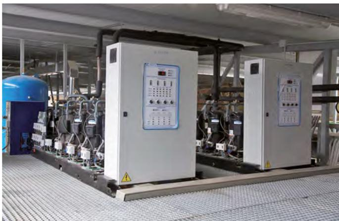
Aún con un 70% más de superficie refrigerada, las dos centrales Scroll Digital logran ahorros energéticos de hasta un 50%.
