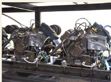
El sistema de diagnóstico inteligente CoreSense™ de los compresores Stream otorga un alto nivel de protección, detección de averías y medición del consumo energético del sistema.
