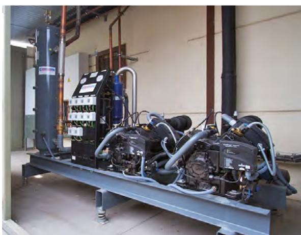
En la foto, central frigorífica de dos compresores Stream diseñada específicamente para cubrir las necesidades de una cámara de envasado y conservación de productos hortofrutícolas.
