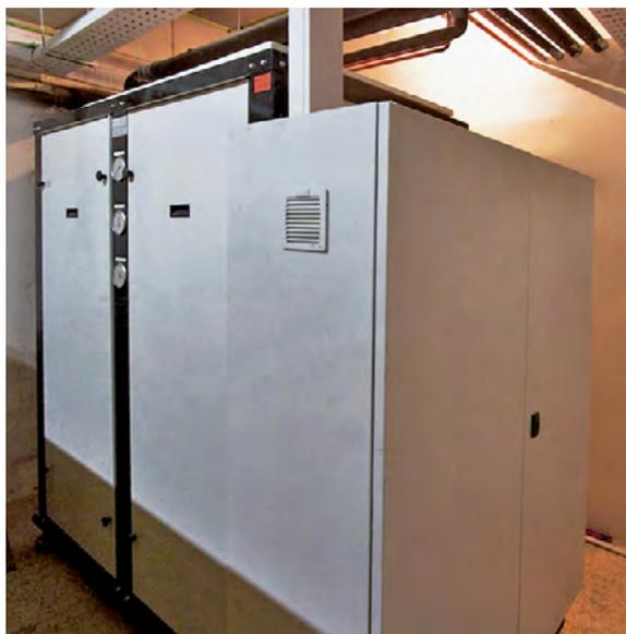
Central Scroll Digital de doble bancada y doble aspiración con descarga común y control de condensación flotante situada en el sótano del local.
