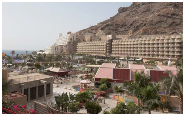
Vista del Paradise Hotel & Resort en el Barranco de Taurito, las Palmas de Gran Canaria.
