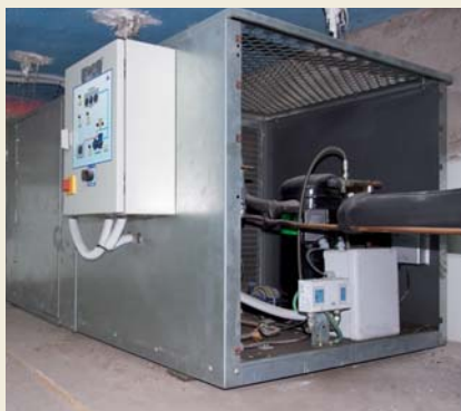
Detalle de la instalación realizada.
