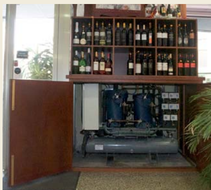
Instalación de la central en el interior de la tienda, oculta en un mueble para vinos.
