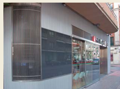
Rejilla desmontable de entrada de aire para la refrigeración de la central frigorífica instalada.
