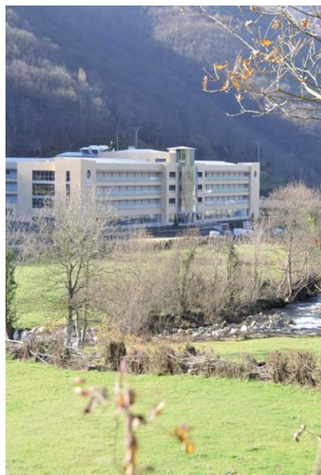
La Residencia de Mayores La Minería de Montepío, en plena naturaleza asturiana, se ubica en un entorno inmejorable.
