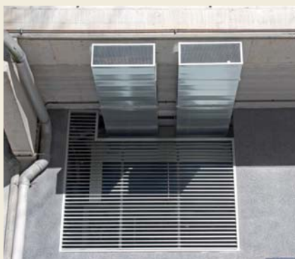
Detalle de los conductos de aspiración.
