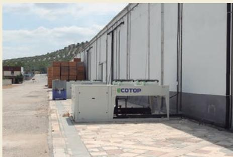
El corazón del Ecotop es su condensador modular de microcanal. Cada módulo de condensación tiene 2 ventiladores y una capacidad de entre 87 y 110 kW.
