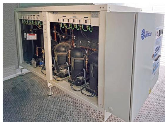
La unidad SZXD Combi de cuatro compresores instalada cuenta con una potencia total de conservación de 33.000 W, temp. evaporación -5°C, y una potencia total de congelación de 4.300 W, temp. evaporación -30°C.
