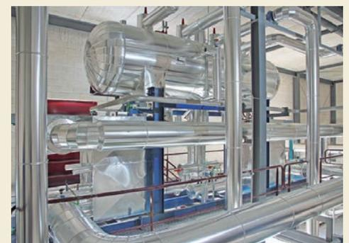
La potencia de refrigeración de los equipos y la recuperación de calor hacen que el agua y el Etilenglicol puedan ser utilizados en las baterías de los secaderos de quesos.
