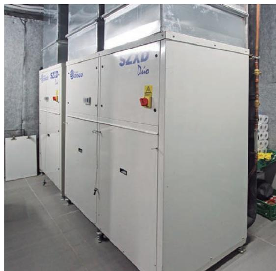
Las dos unidades condensadoras SZXD Duo se ubicaron en la sala de máquinas del local y destacaron por su sencilla instalación, diseño compacto y bajo nivel sonoro.
