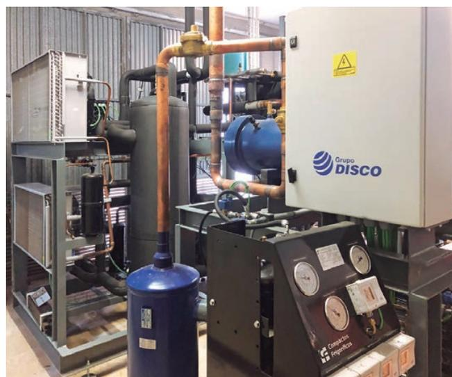
Las dos centrales instaladas llevaban compresores semiherméticos Copeland para CO2 subcrítico y en cascada con refrigerante R513a.
