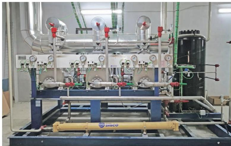
La instalación está diseñada para dar servicio a tres sistemas frigoríficos diferentes: túnel de congelación, cámaras de congelados y un sistema frigorífico de enfriamiento de propilenglicol para servicios de refrigerados.
