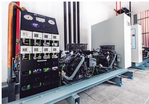
La nueva instalación incorpora compresores Stream, válvulas de expansión electrónica y condensación flotante.
