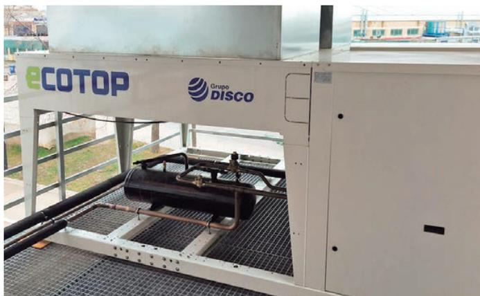
El equipo Ecotop es una unidad condensadora de alta calidad diseñada para intemperie que cuenta con un novedoso sistema modular único en el mercado.
