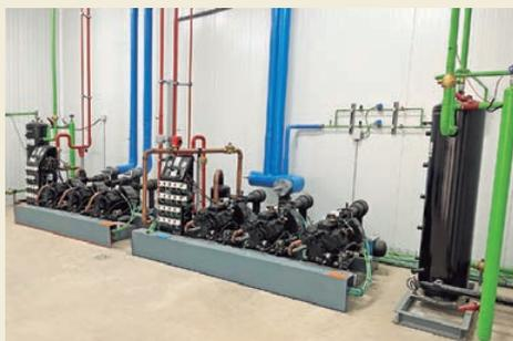
Las centrales frigoríficas con compresores Stream y CoreSense atienden las salas y cámaras de frescos.
