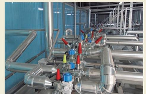
El uso de válvulas de seguridad y detectores de amoníaco junto con control preciso de todos los componentes del sistema mitigan los riesgos de seguridad de este tipo de instalaciones.
