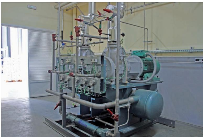
Central 2XI160S-M Mycom con 2 motores de 110 kW con variadores de frecuencia en cada uno de ellos, separador de aceite de 3 etapas, enfriador de aceite multitubular con V3V y bomba de circulación de amoníaco de reserva.
