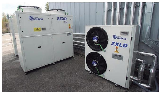
Las dos unidades SZXD mantienen el muelle de carga y descarga de producto a temperatura de frescos mientras que la unidad ZXLD, con sistema EVI, se encarga de la cámara de congelados.
