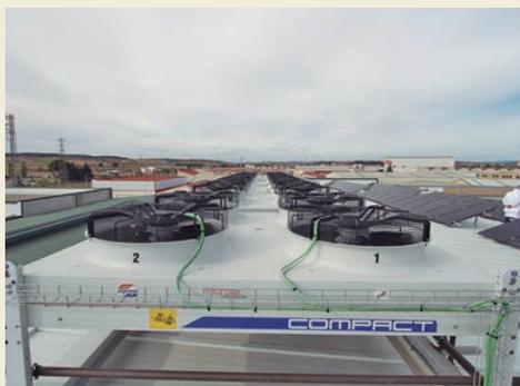
Se incluyeron 13 condensadores microcanal para disminuir la carga de gas R449A.
