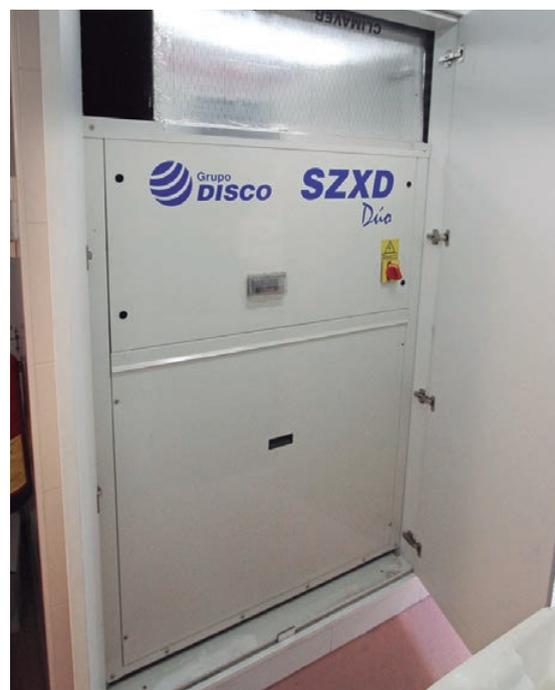
La sustitución de varios equipos independientes por la unidad SZXD significó un ahorro de espacio, reducciones de costes de equipo y de mantenimiento, así como de consumo energético y nivel sonoro.
