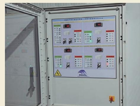
Cuadro de control con visualización instantánea de funcionamiento del túnel de congelación, sala de deshuese y cámaras de mantenimiento de congelados.
