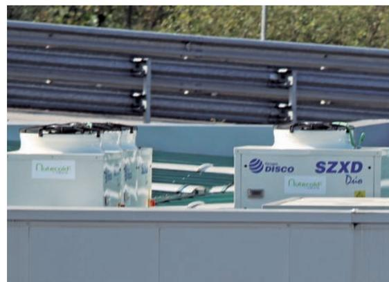
Las unidades condensadoras se situaron en la terraza exterior de la azotea del supermercado. Al venir preconfiguradas de fábrica, su instalación es rápida y sencilla.
