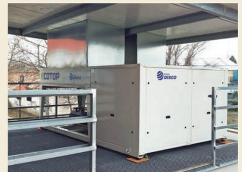
La solución modular del Ecotop da lugar a numerosas combinaciones de compresores, pudiendo adaptar la potencia del condensador, añadiendo el número de módulos de condensación necesarios
