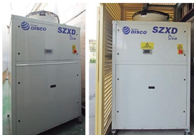
La unidad SZXD, no necesita de sala de máquinas ya que puede ubicarse en cualquier sitio, interior o exterior. El diseño compacto del equipo facilitó las labores de instalación del mismo en un patio de reducidas dimensiones y difícil acceso.
