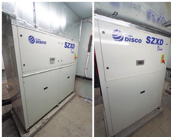
Las unidades SZXD Dúo y Trío son equipos plug & play multiservicio y multirefrigerante aptas para aplicaciones de media y baja temperatura completamente equipadas, listas para conectar y hacer la puesta en marcha.
