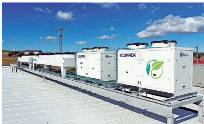
Los dos equipos Ecopack, 4MT-22X y 6MM-30X, que dan servicio a dos cámaras de congelados, se ubicaron en la azotea del edificio.
