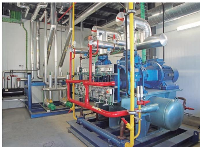
Central 2X1160S-M Mycom con 2 motores de 110 kW con variadores de frecuencia en cada uno de los motores, separador de aceite de 3 etapas, enfriador de aceite multitubular con V3V y bomba de circulación de amoníaco de reserva.
